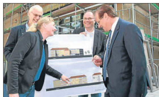
Baustellentour: Landrat Bernhard Reuter (rechts) mit Bauleiterin Erika Falk, Gebäudemanager Hertmut Becker und dem kommissarischen Schulleiter Reiner Wiemann. Foto: per
