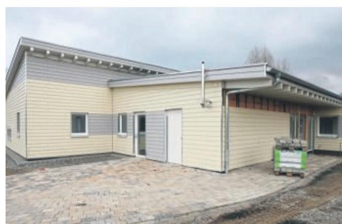
Neue Kinderkrippe in Dransfeld: Der Neubau ist fertig, am 1. Februar soll der Betrieb beginnen.
