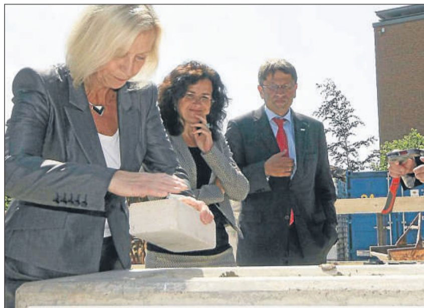
Passt: Bundeswissenschaftsministerin Johanna Wanka setzt einen Grundstein. Landeswissenschaftsministerin Gabriele Heinen-Kljajic schaut ebenso zu wie UMG-Vorstand Prof. Hayo Kroemer. Foto: Kopietz
