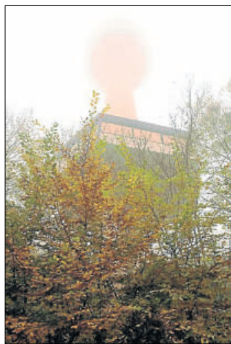
Wird vor dem Verschwinden im Nebel bewahrt: Der Gaußturm kann ab sofort gemietet werden. Foto: Schröter
