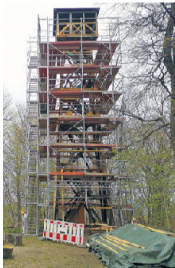
Eines der unterstützten Projekte ist die Sanierung des Hünstollen-Turmes im Göttinger Wald. Foto: Privat
