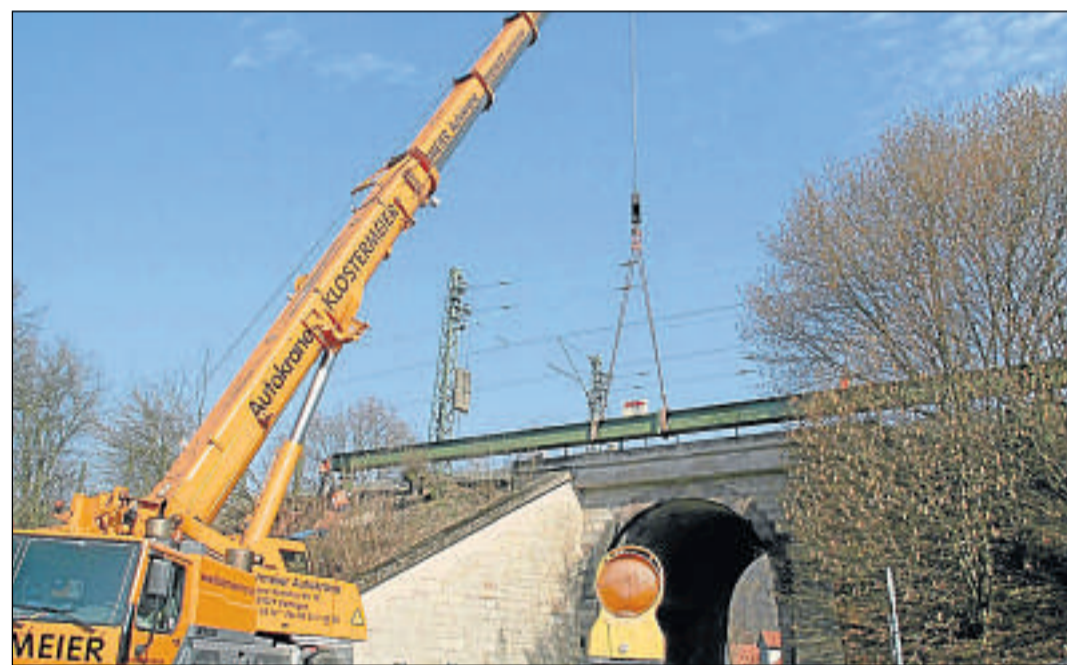
In Bonaforth war der Auftakt: Die Bewohner des Fuldadorfes erhielten als erste in Hann. Münden Lärmschutz an der Bahnlinie. Das Foto vom März 2010 zeigt einen Schwerlastkran, der Stahlträger für die Lärmschutzwände auf die Eisenbahnbrücke hievt. Archivfoto:Krischmann
