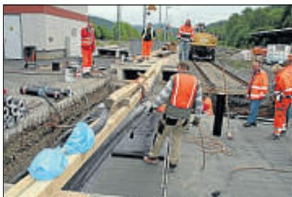
Tunneldach: Mit Bahnen aus Polyvlies dichten die Bauarbeiter die Oberfläche ab, sodass kein Wasser eindringen kann. Foto: Krischmann
