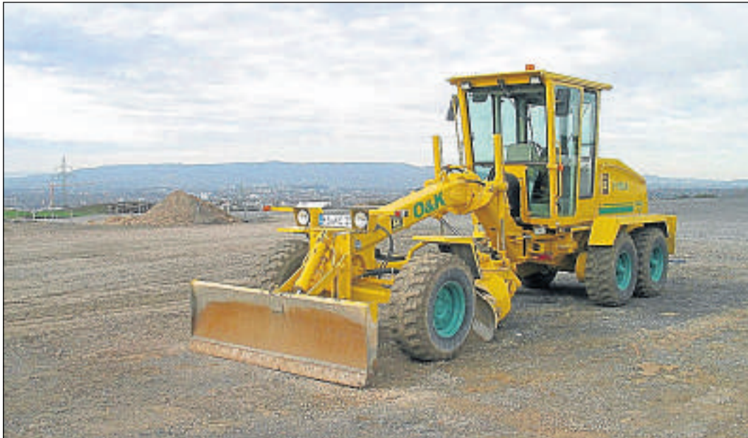
Blick nach Kassel: Der Sandershäuser Berg ist eine Großbaustelle, die Firma SMA bereitet hier den Boden für weitere Gebäude. Ob das Gewerbegebiet vergrößert wird und einen eigenen Autobahnanschluss erhält, ist noch offen.
