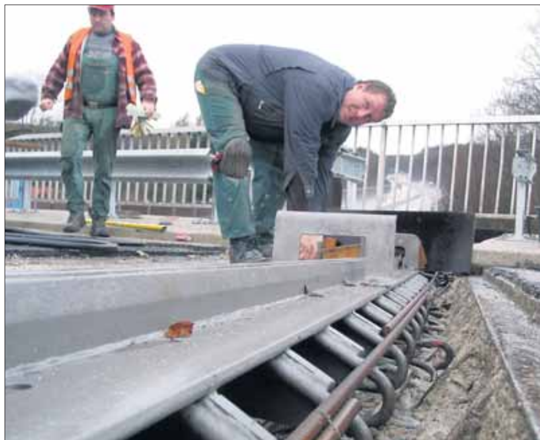
Wurde gestern eingebaut: Polier Matthias Köhler von der Firma GFB aus Sachsen-Anhalt legte gestern letzte Hand an der Übergangskonstruktion an. Anschließend kam Beton rein, der zwei Tage aushärten muss. FOTO: TILL
