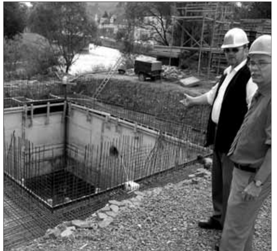
Mitte Juli: Damit der Betonklotz bei Hochwasser nicht aufgetrieben werden kann, wird drumherum noch ein Kragen aus Stahlbeton angefügt. Der Leiter der Stadtentwässerung, Joachim Schelper, und Erster Stadtrat Friedhelm Meyer (vorn) sind mit dem Fortgang der Arbeiten zufrieden.
