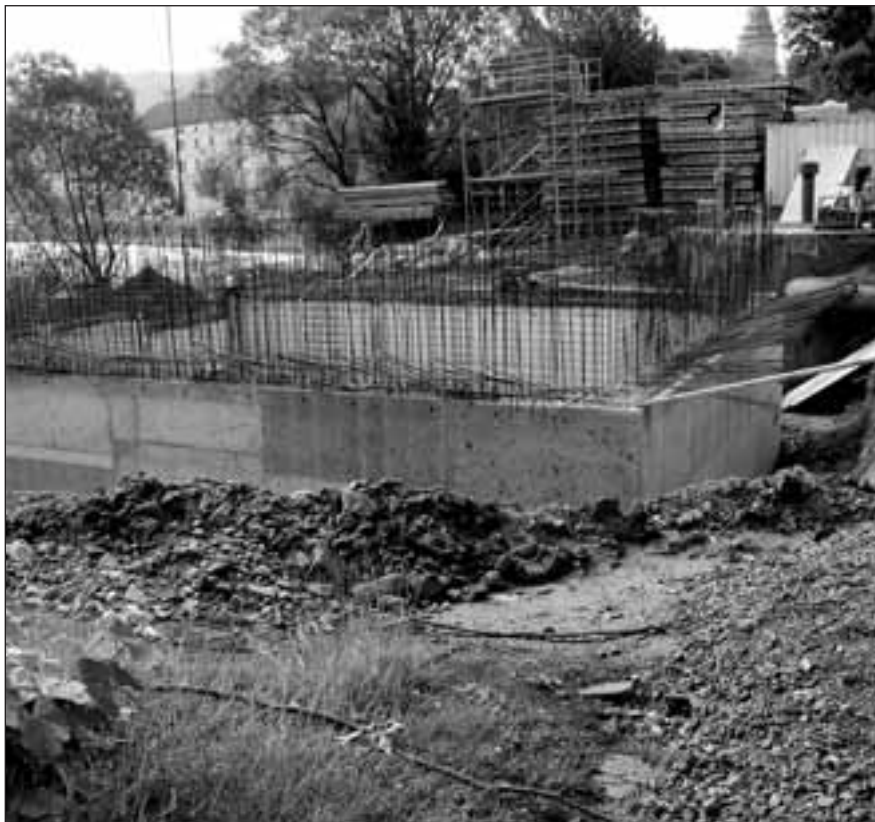
Ende Juni: Genau 5,5 Meter ragte der Rohbau des Gebäudes ursprünglich aus dem Boden. Zentimeterweise sackte er ab. Noch hat er die vorgesehene Tiefe nicht erreicht. Im Innern aufgestellte Pumpen saugten das Grundwasser und den einströmenden Sand unentwegt ab.
